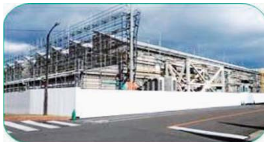
お疲れさま! 建五工場解体万全の準備!
